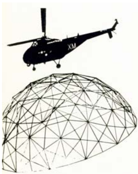
Fig. 5 – Transporte con helicóptero de una cúpula geodésica. Buckminster Fuller, 1953.
